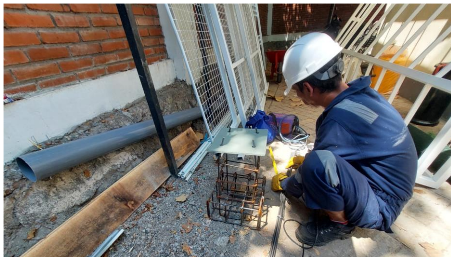
Gambar 3.6 Perakitan rangka dan anchor bolt untuk pondasi Rumah Anggrek
