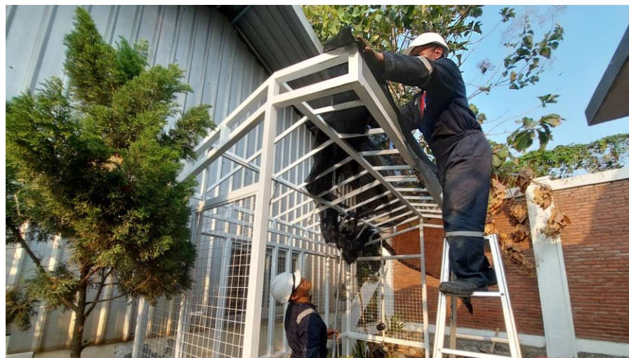
Gambar 3.9 Pemasangan stepping stone untuk lantai (foto atas) dan paranet untuk atap (foto bawah) unit Rumah Anggrek
